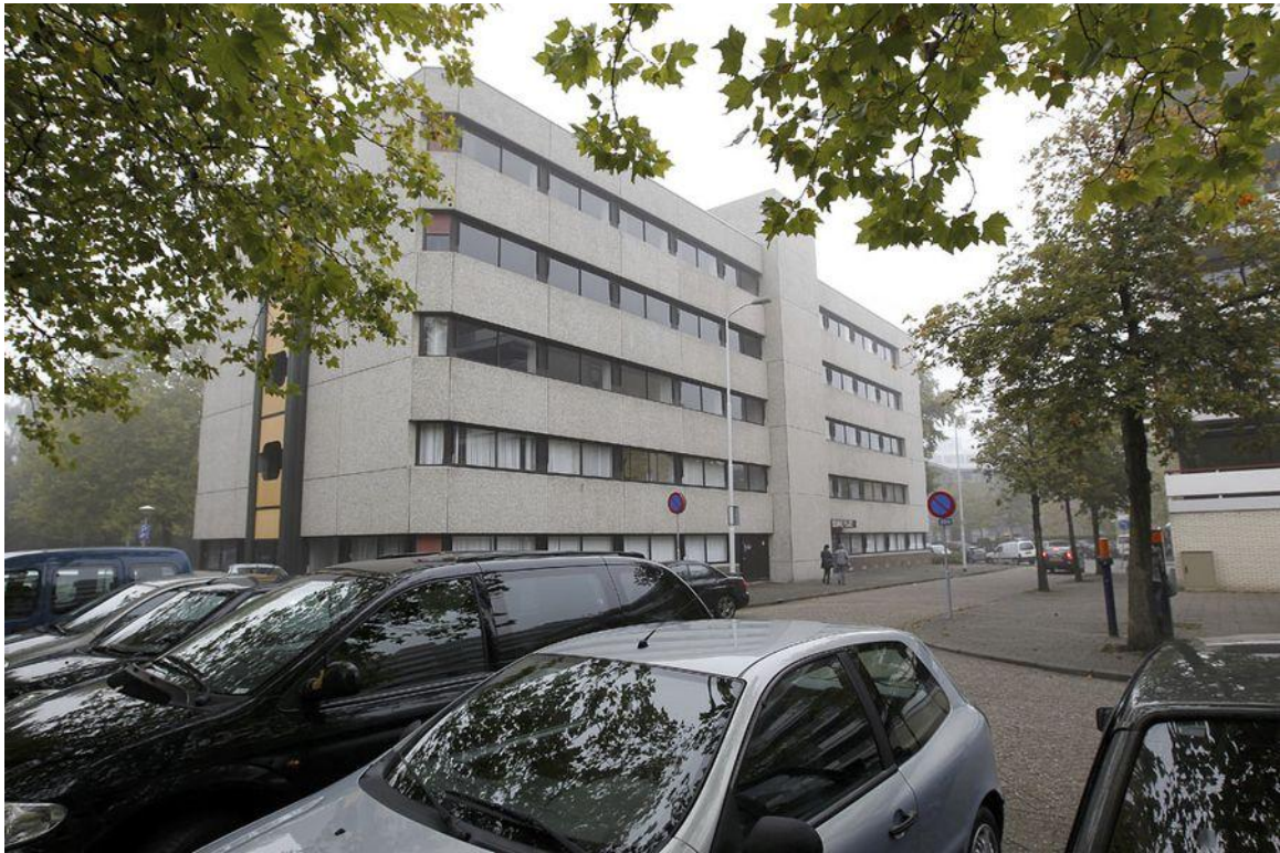
De Bomansplaats voor de renovatie/transformatie
