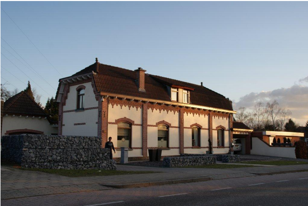
Afbeelding 2.2.1 Mijnwerkerswoningen uit de voormalige mijnwerkerskolonie Rennemig , Schelsberg Heerlen (Beersdal)
