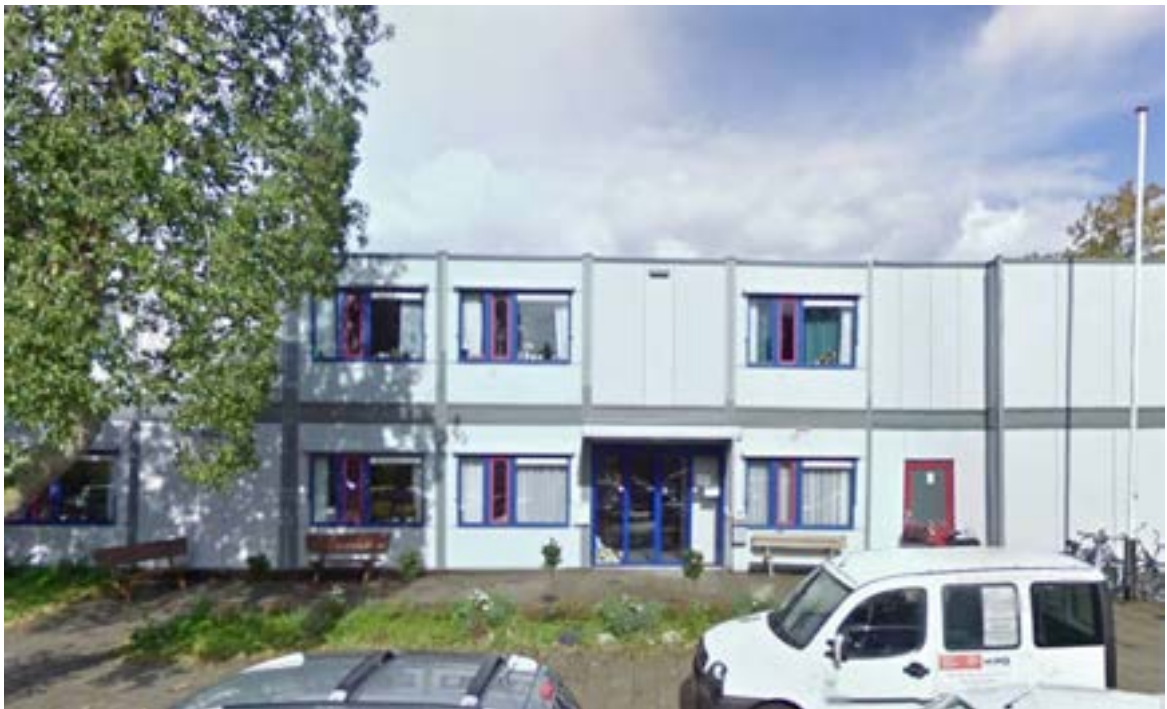
Verplaatsbare zorgwoningen, Nieuwerkerk a/d IJssel
