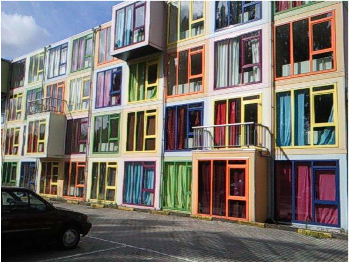
Verplaatsbare jongerenhuisvesting in Zaandam, Studio City
