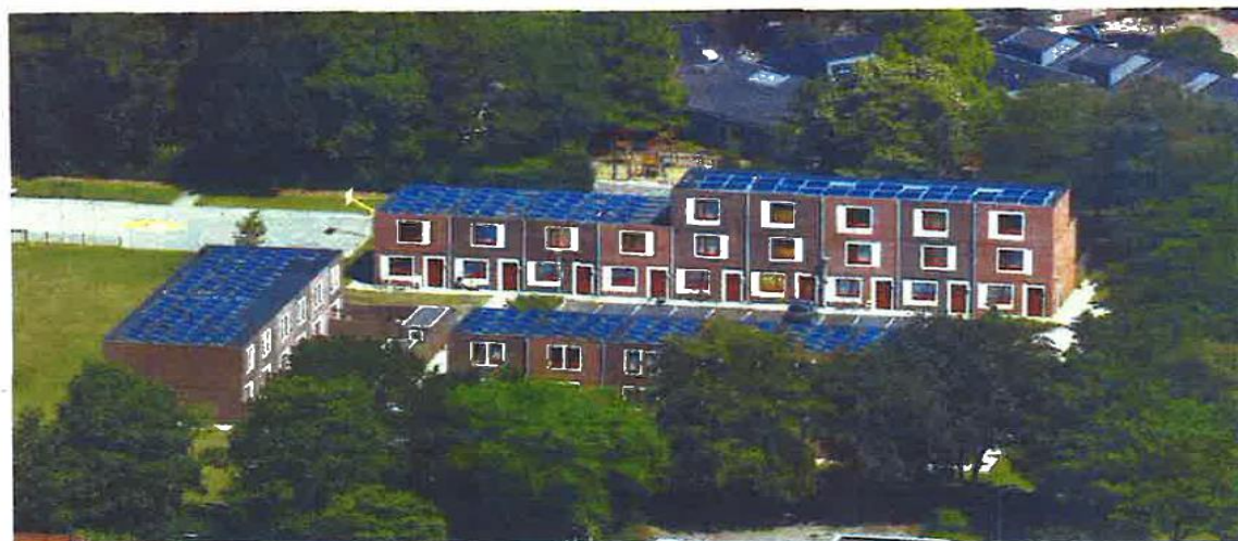
De 22 prefab-woningen voor statushouders aan de Lijsterhof in Barneveld is een voorbeeld van een flexibele woonvorm.
